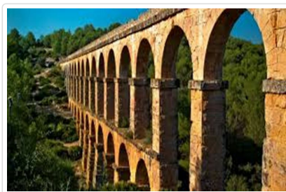
塔拉戈納千年水道橋
