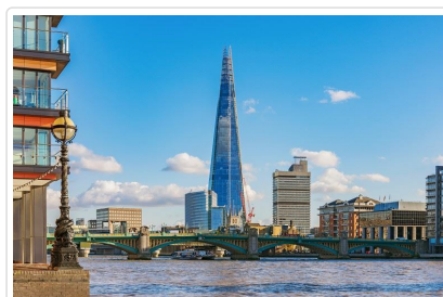
西歐最高摩天樓—夏德塔登頂
