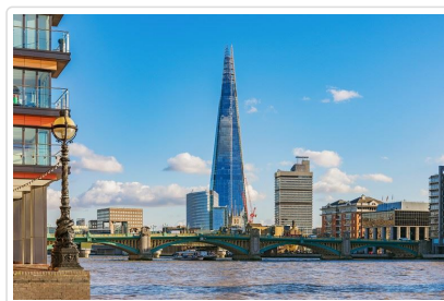
西歐最高摩天樓—夏德塔登頂
