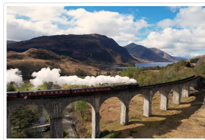
格倫芬南高架橋
