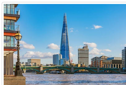
西歐最高摩天樓—夏德塔登頂
