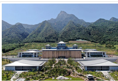
杭州國家版本館
