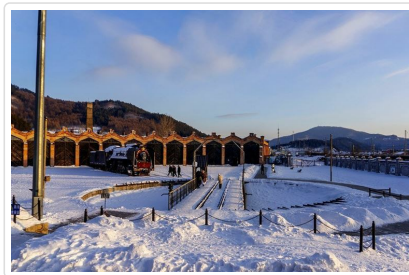
橫道河子鎮 中東鐵路機車庫
