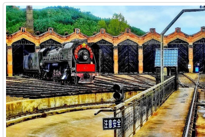
橫道河子鎮 中東鐵路機車庫
