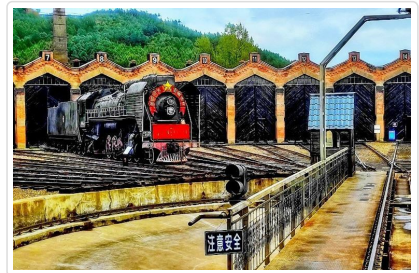
橫道河子鎮 中東鐵路機車庫
