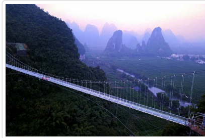
荔江灣翔龍玻璃橋
