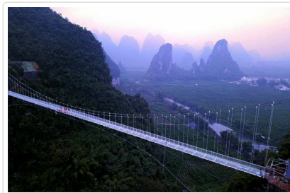
荔江灣翔龍玻璃橋
