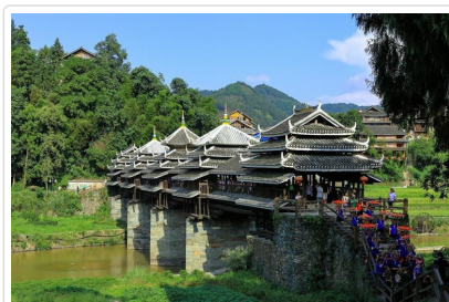
程陽八寨 風雨橋
