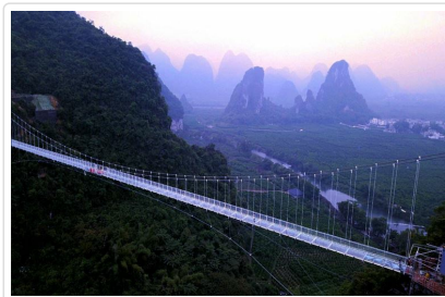
荔江灣翔龍玻璃橋
