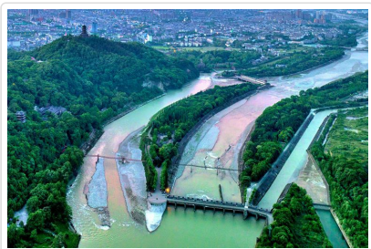
都江堰 水利工程
