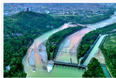
都江堰 水利工程
