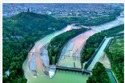
都江堰 水利工程
