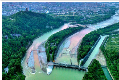
都江堰 水利工程
