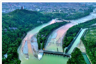
都江堰 水利工程
