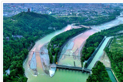
都江堰 水利工程
