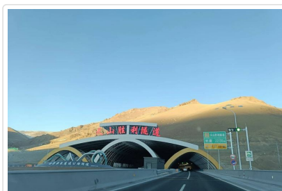
天山勝利隧道
